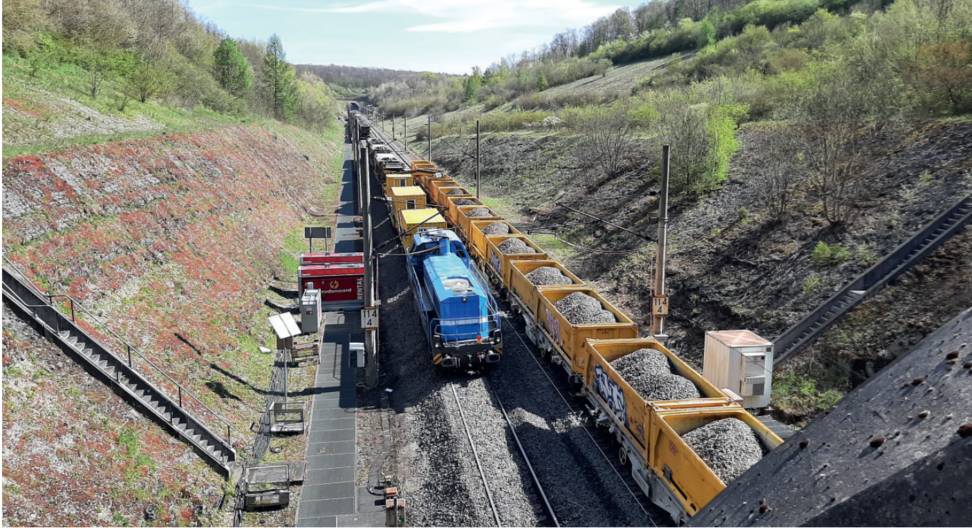
Bild 6: Auf der SFS 1733 wurden insgesamt ca. 95.000 t Schotter getauscht
